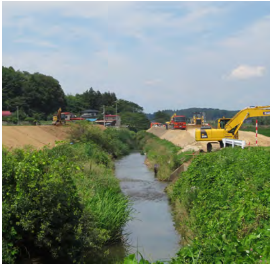
阿由里川かさ上げ工事
