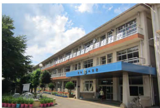
ゼロエネルギーを目指した改修を行う矢吹小学校
