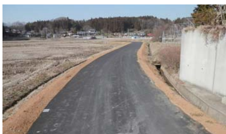
三城目地区農道舗装工事
