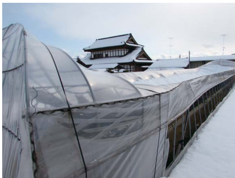
大雪により倒壊したパイプハウス
