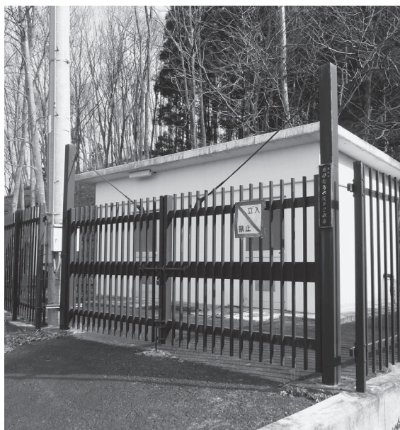
西部簡易水道第2水源（田内）
