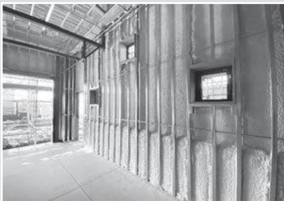
▲壁下地施工状況（車庫）
