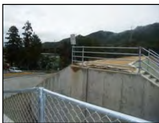
警告看板の設置
