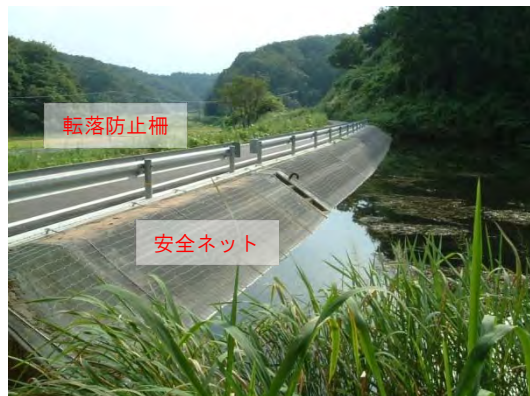
堤体法面に設置した安全ネット
