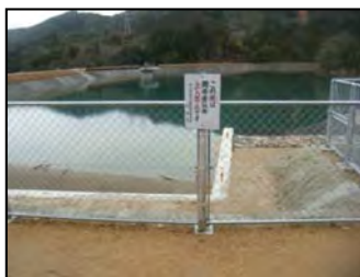
警告看板の設置
