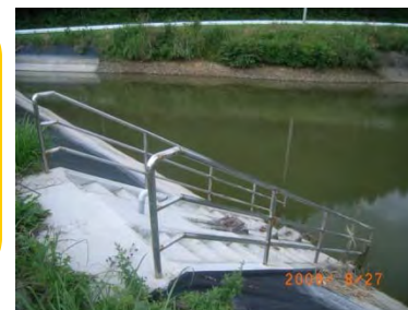
取水口階段・手摺設置状況
