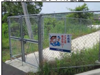
進入防止フェンスの設置
