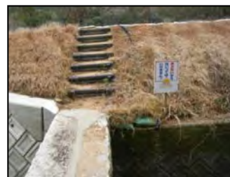
警告看板の設置
