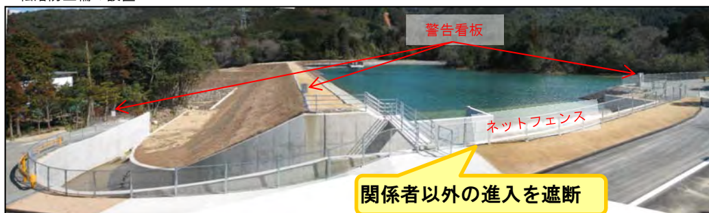
転落防止柵の設置
