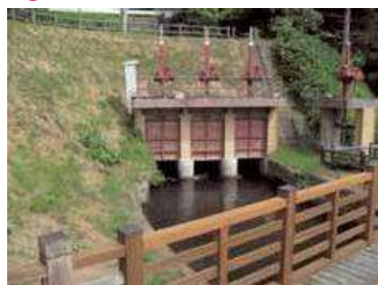
② 天狗山トンネル入口
