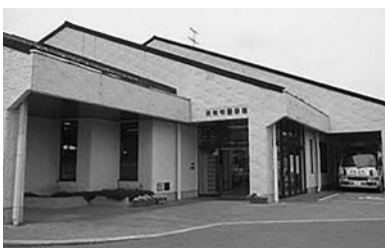
旧矢吹町図書館
