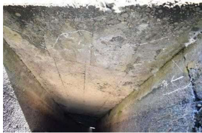
床版下面の剥離
