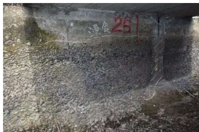
下部工の欠損 (浸食)
