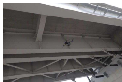
ドローンによる桁下の点検
