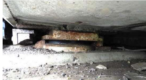
支承サイドブロックの破断
