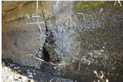
下部工の欠損 (浸食)
