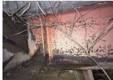
主桁端部の腐食(板厚減少)
