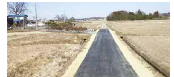
総延長 L=40.0m幅員 W= 2.5m (位置:大久保地内)
