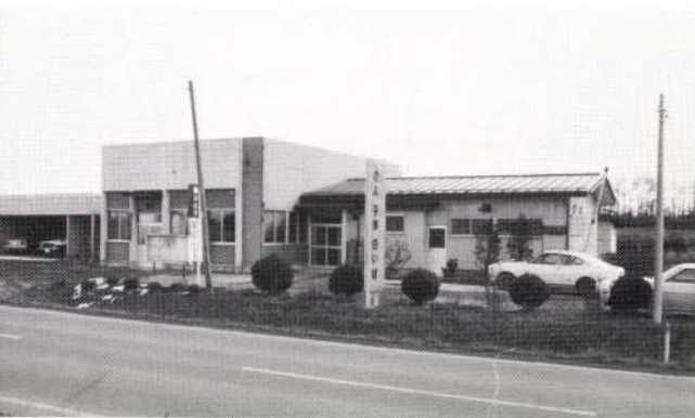
白河警察署矢吹警察官派出所 （昭和50年2月新築移転）
