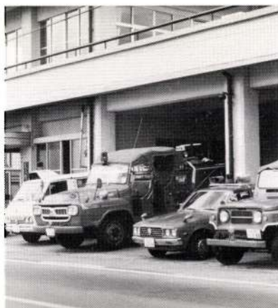
白河地方広域市町村 圏消防署矢吹分署 （昭和47年3月新築）
