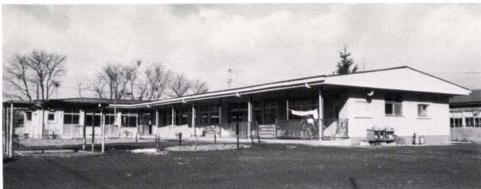
矢吹ひがし保育園 (昭和53年4月竣工)
