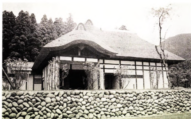
【写真148】移築竣工の陣屋（提供 会津武家屋敷）
