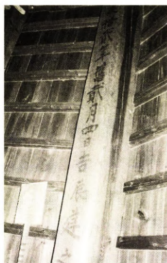
【写真98】土蔵内部墨書 （藤井義進家）
