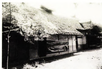
【写真144】移築前の主屋・正面
