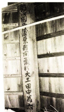
【写真97】土蔵内部墨書 越後 大工（間瀬大工）田 中為六の名がみえる （藤井義進家）
