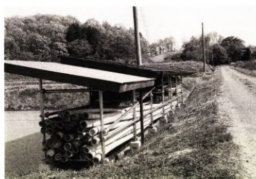
【写真25】 ハセ杭置場
