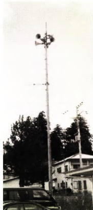
【写真35】矢吹町防災無線
