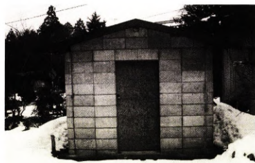
【写真16】本村中丁膳枕小屋
