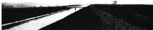
泉川河川改修がなされ、永久橋が建設された。基盤整備された左は水田、右は畑である。中央には建設された野菜ハウスが、遠くに国神館が見える。
