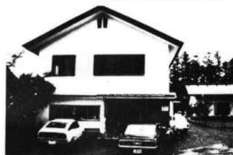
矢吹町商工会館
