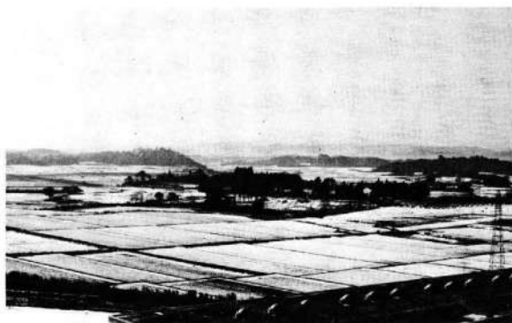
完成した矢吹ガ原開拓水田
