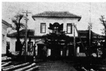
西白河郡役所（白河町道場小路）
