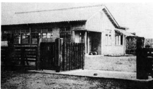
矢吹高原国営開墾事務所 農林省矢吹高原国営開拓事務所は、昭和16年(1941)西白河郡矢吹原開拓(旧矢吹町・中畑村・三神村・泉崎村踏瀬)及び岩瀬郡にわたる水田開拓のため、農林省が設立したものである。矢吹町石川通り(一本木)
