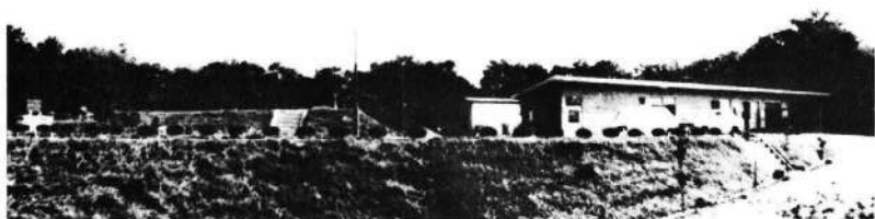
矢吹上水道 稲荷釜（昭和43年9月給水開始）
