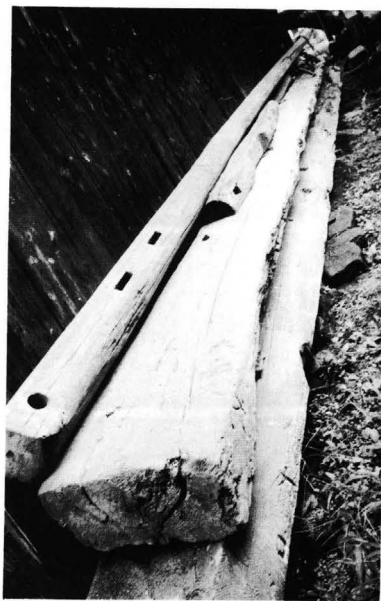
仮橋用材 (大和久)
