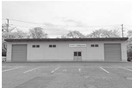
災害備蓄倉庫
