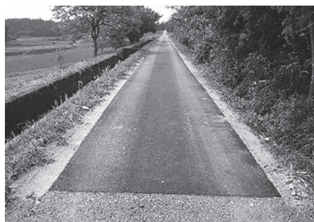
総延長L=120.0m 幅員W=2.0m (位置:矢吹町大池地内)
