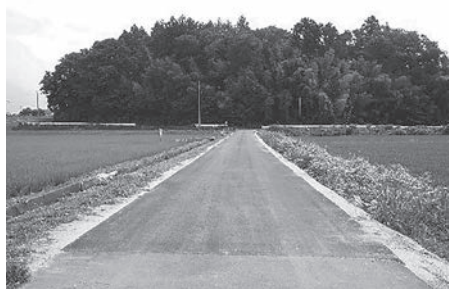
総延長L=61.2m 幅員W=2.7m (位置:矢吹町大久保地内)
